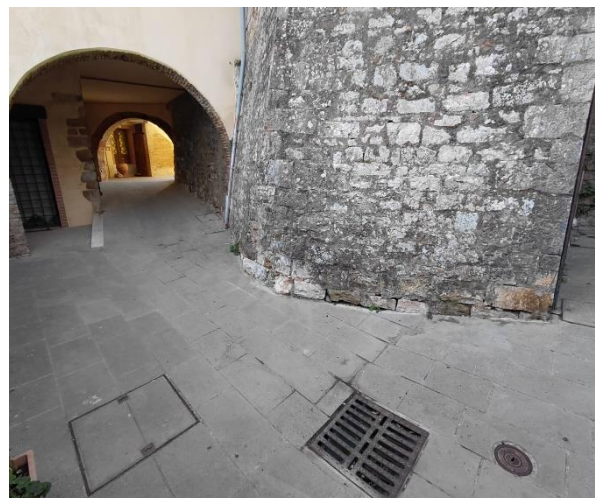
14 rampa per via Solferino, da via Curtatone
