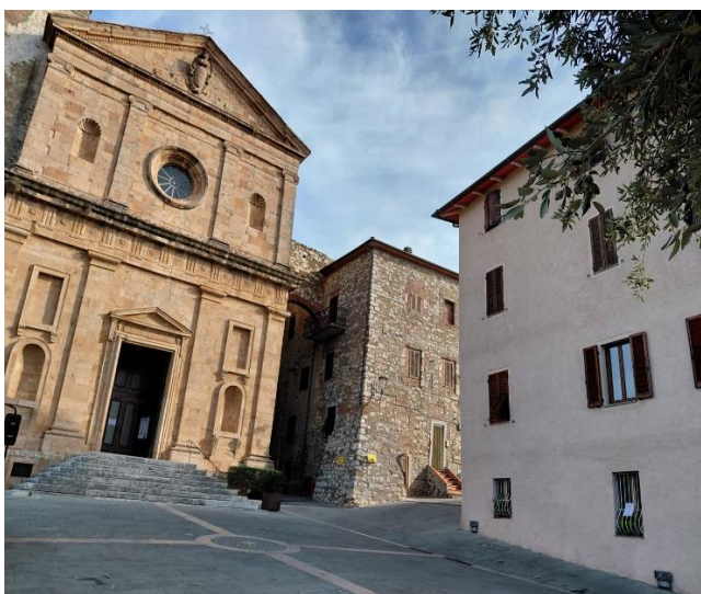
5 rampa verso Chiesa San Biagio
