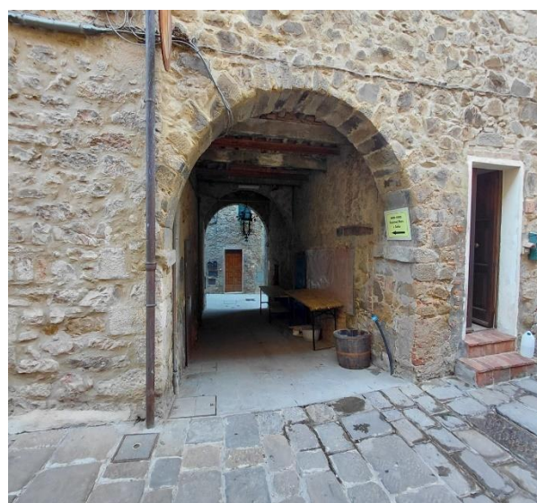
10 passaggio con rampa da via Montanara a via Curtatone
